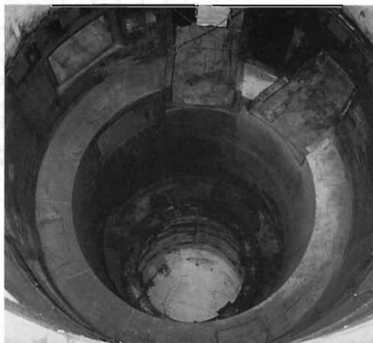
Photo. 圧力容器を撤去した生体遮蔽壁内面
